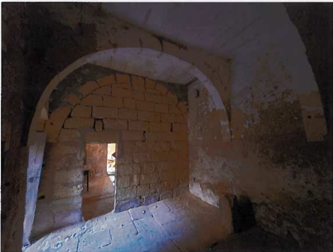
Ritratt Nru. 4 - Dehra nterna tal-kamra mmarkata bin-numru 1 (ara Dok. MA3i). Fl-isfond jidher il-bieb li attwalment jgħaqqad il-fond ma' dak bin-numru uffiċċjali 25.
