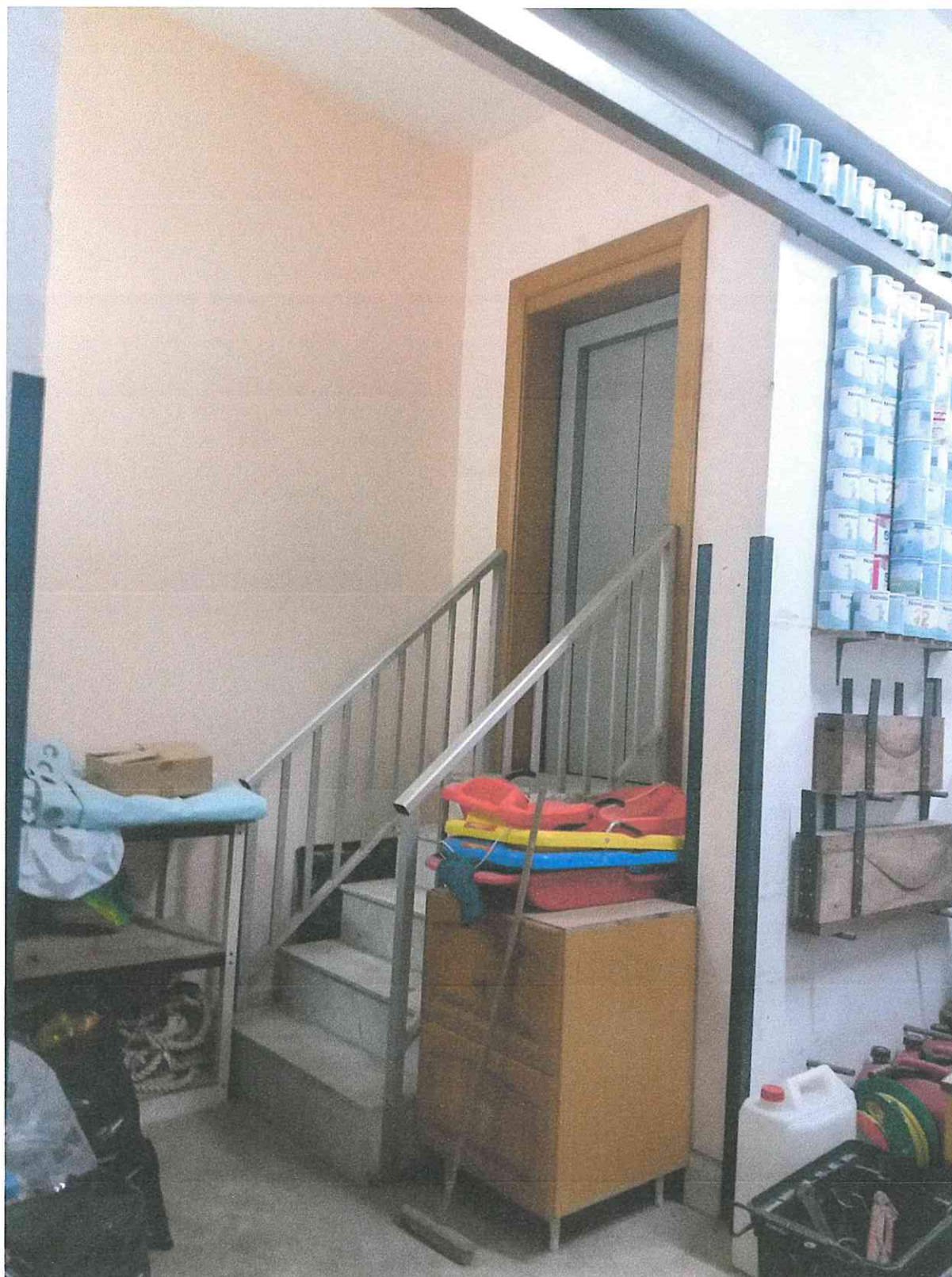
Ritratt tal-aċċess għal-lift mill kantina.
