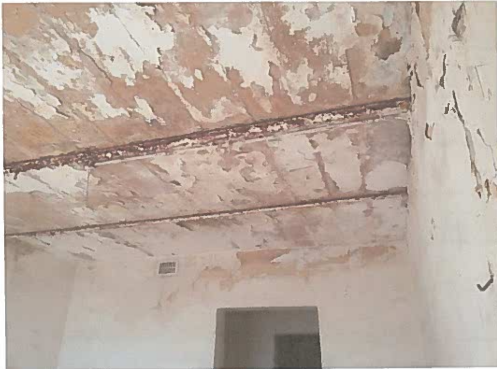
P21: - L-istat hazin tal-hitan, u is-saqaf tal-Kamra: 7. Ix-xorok tal-gebel tat-tieni sular tmermru u it-travi tal-hadid issaddu
