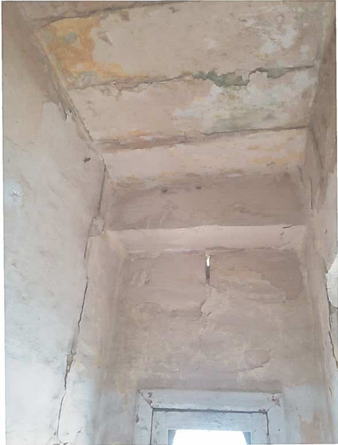
P25: - L-istat hazin tal-hitan u is-saqaf tal-Kamra: 8. Konsenturi ukoll fil-hitan
