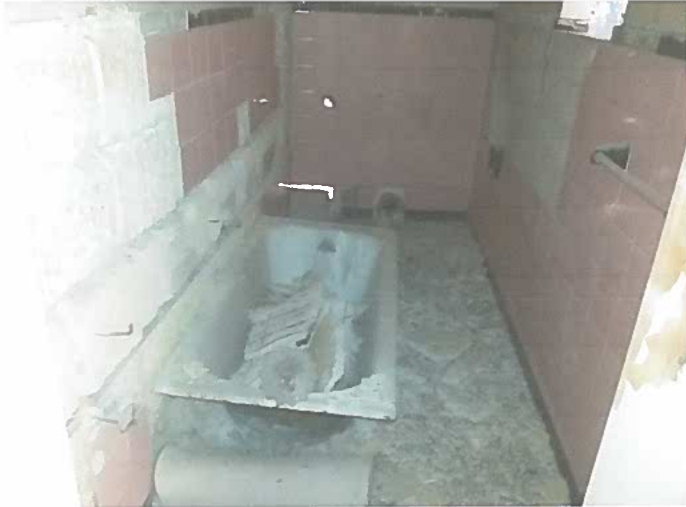
P19: - L-istat hazin tal-ħitan, u is-saqaf tal-Kamra: 5 li suppost hi l-kamra tal-banju. Is-saddid mix-xibka tas-saqaf faqqa il-konkos ta' taht is-saqaf u waqa' fl-art
