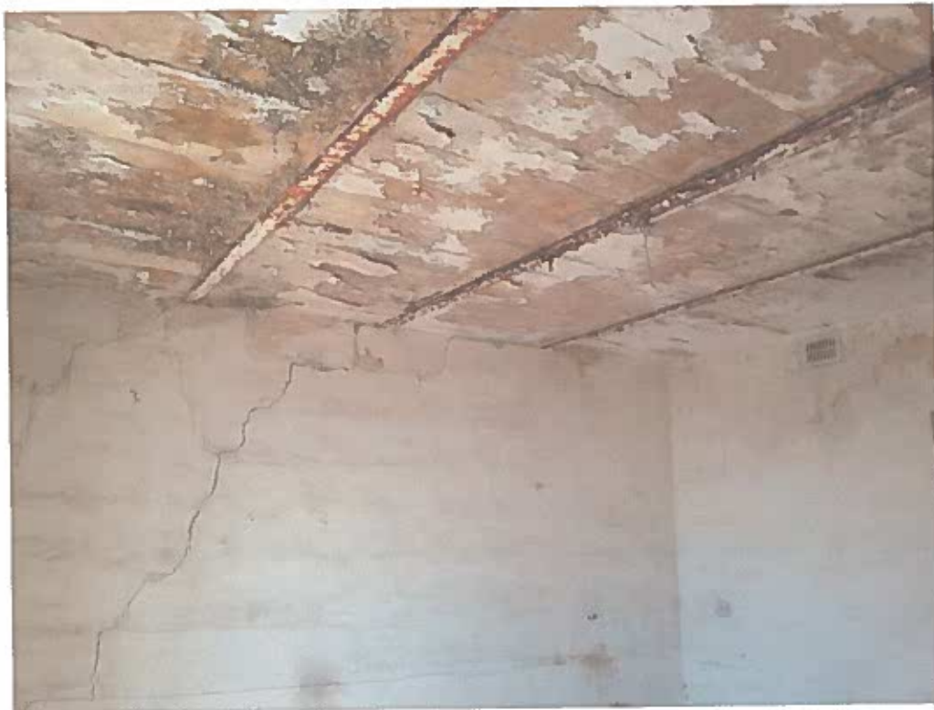
P22: - Ġew innutati konsenturi imdaqsa fil-kamra:7 neżlin ma tul il-fili tal-hitan
