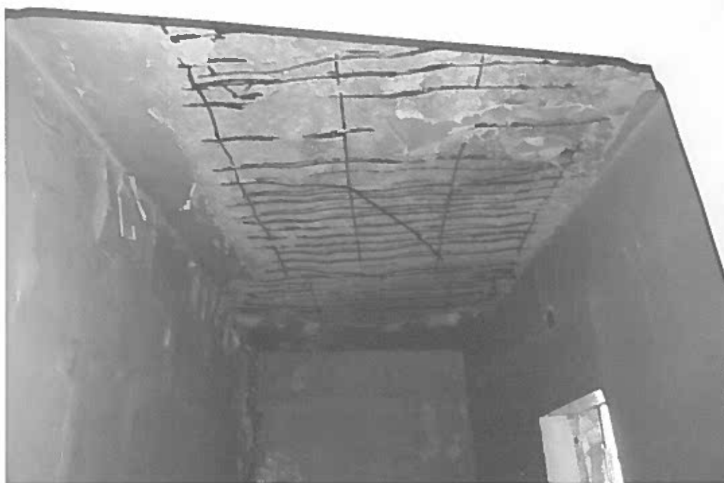
P18: - L-istat hazin tal-hitan, u is-saqaf tal-Kamra: 5. Is-saddid mix-xibka tas-saqaf faqqa il-konkos ta' taht is-saqaf u waqa' fl-art
