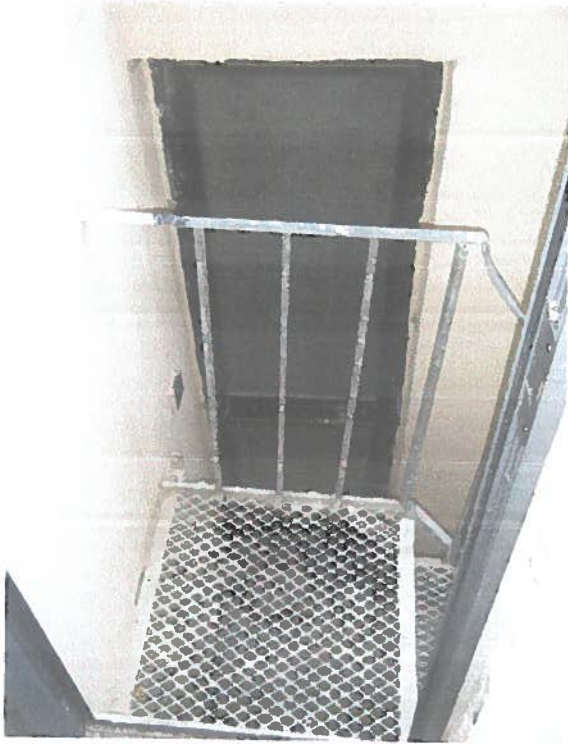
Tarag u strutturi gewwa l-bitha
