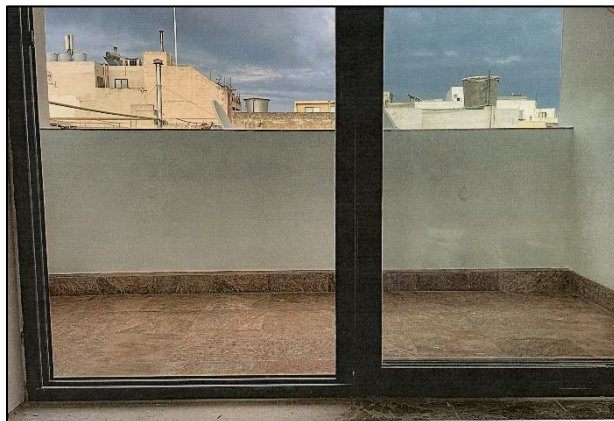
It-terrazzin 'il ġewwa mill-ħajt intern
